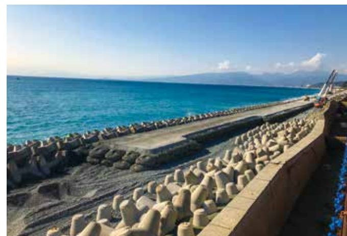
西湘バイパス災害復旧
